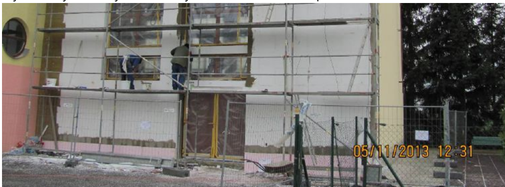
Zateplování tělocvičny po výměně oken a dveří.
